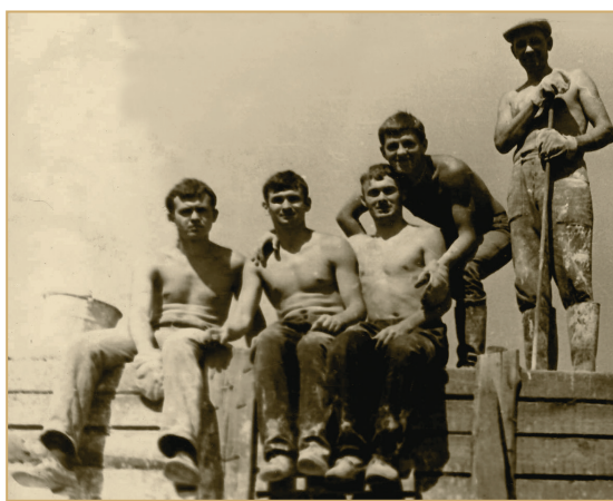
Влітку на будівництві житлового монолітного будинку в перестановчій опалубці, останній щит. Зліва направо: М. Катрич, В. Ткач, В. Нікулін, А. Андріанов, А. Катрич (ІІІ курс, 1973 р.)
