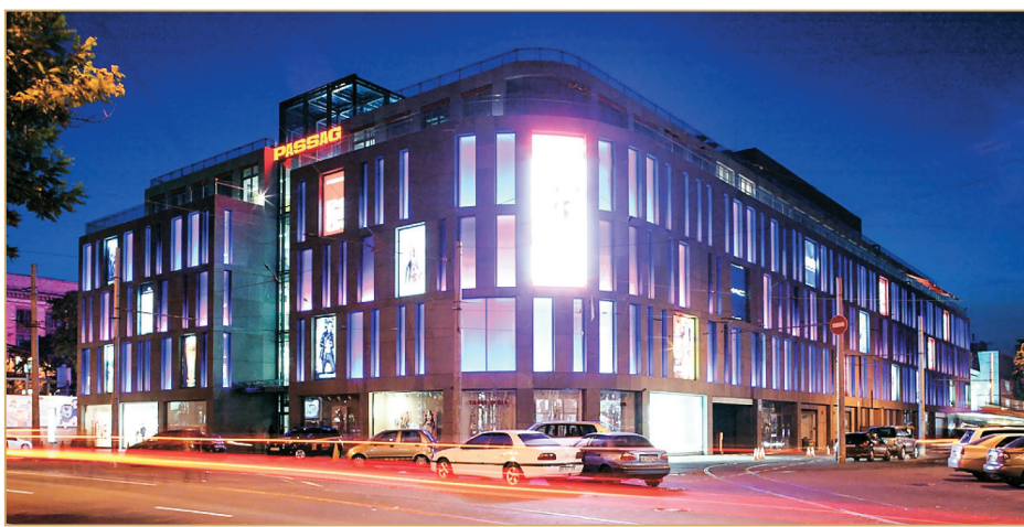
Торговий комплекс «Пасаж», 2010 р., м. Дніпро. Загальна площа — 25100 м 2
