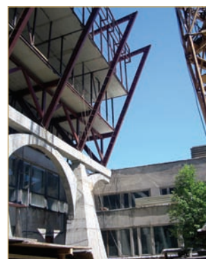
Актовий зал Національного лісотехнічного університету України в процесі будівництва
