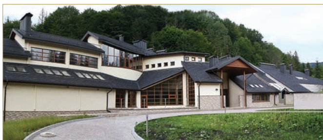
Санаторно-оздоровчий комплекс «Прикарпаття» в м. Яремче
